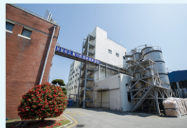
1969 화학 사업 진출 전주 폴리에스테르 공장 준공
